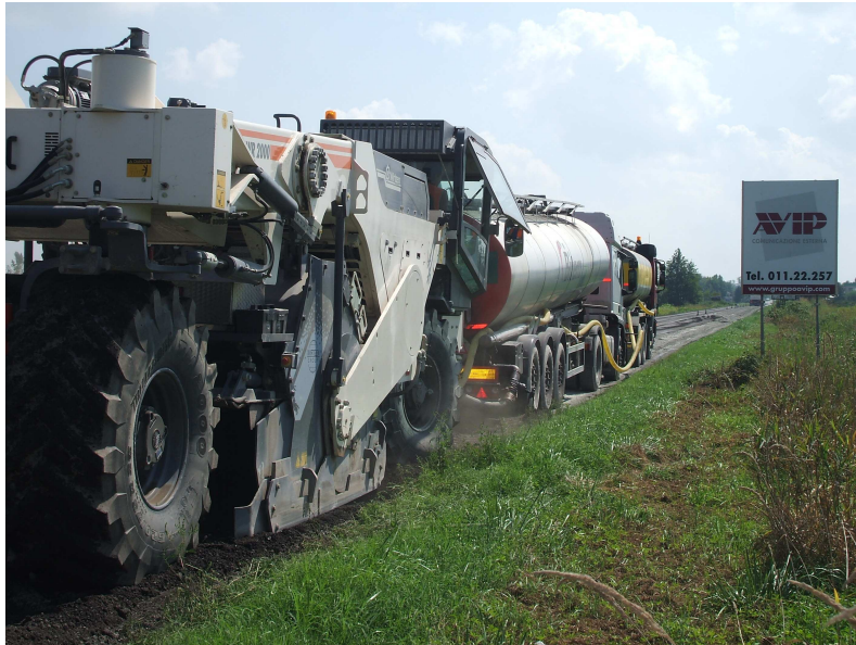
Fig. 5 – Riciclaggio in situ
