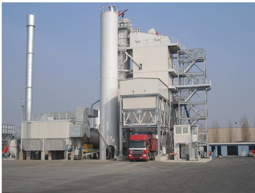
Fig. 4 – Impianto Conglomerati Bituminosi
