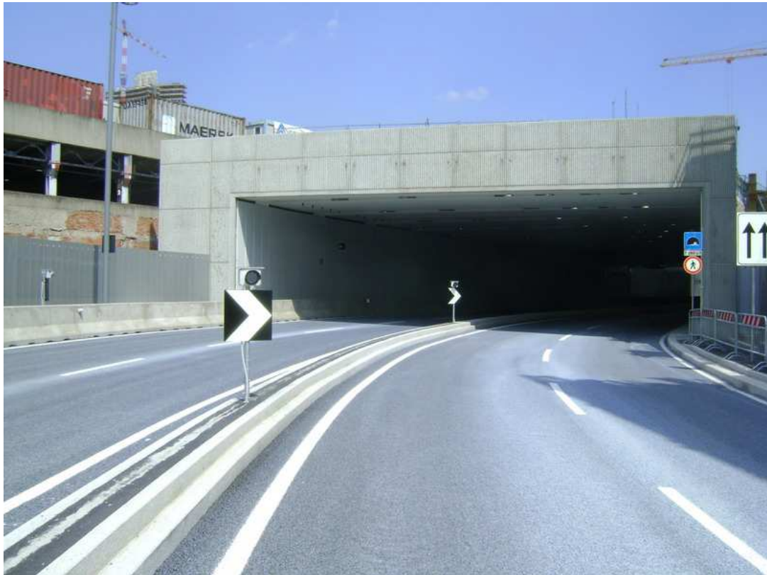
Fig. 3 – Pavimentazione Stradale Trattata con Coverlite®
